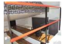
01 手すり A ランク
