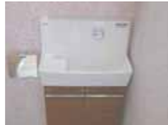
03 トイレ手洗 A ランク
