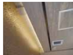
07 間接照明 S ランク
